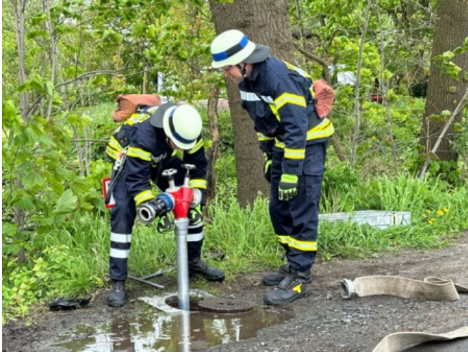
Ein Trupp beim setzen eines Standrohrs auf den Unterflurhydranten
