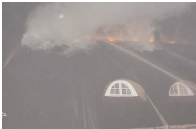
Bei Eintreffen der ersten Einsatzkräfte, schlugen bereits Flammen aus dem Dachfirst.
