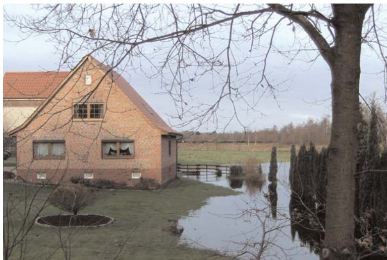
Verstopftes Rohr und starker Regen sorgten für aufgestautes Wasser im Garten Foto: Timm Meyer
