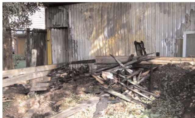
In der Iseler Straße wurde gelagertes Feuerholz angesteckt, das die Holzkonstruktion der Lagerhalle schon schwarz werden ließ. Foto: Frank Bartmann
