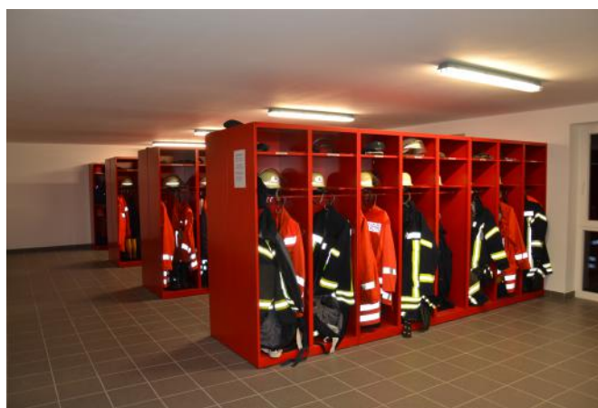
Mit etwa 81 Quadratmetern ist der Umkleideraum mit der Einsatzbekleidung der Ebersdorfer Feuerwehr großzügig bemessen und stellt jetzt keine Unfallgefahr mehr da
