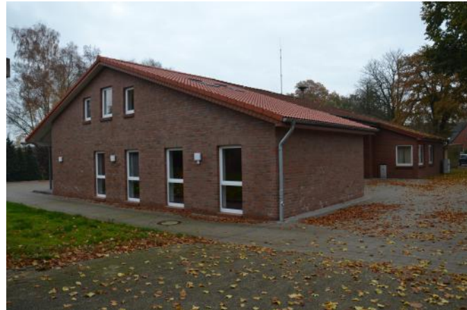
5000 Stunden Eigenleistung investierten die Kameraden der Feuerwehr Ebersdorf an ihren Anbau am Feuerwehrhaus, das am Freitagabend offiziell eingeweiht wurde
