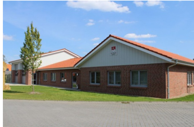
Das 1,3 Millionen Euro teure Feuerwehrgerätehaus ist eine Investition für die Einsatzkräfte der Ortsfeuerwehr und auch gleichzeitig die Umsetzung des aktuellen Feuerwehrkonzepts 2020.
