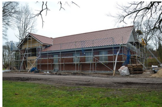
Bietet den 35 Kameraden Platz auf etwa 260 Quadratmetern: das künftige Feuerwehrgerätehaus der Ortsfeuerwehr Mehedorf, das im Mai übergeben werden soll.
